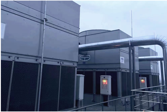
製冷系統板換和冷卻塔
