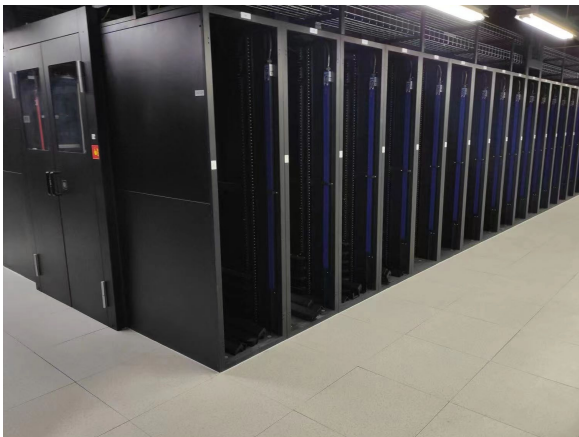
冷通道封閉系統
